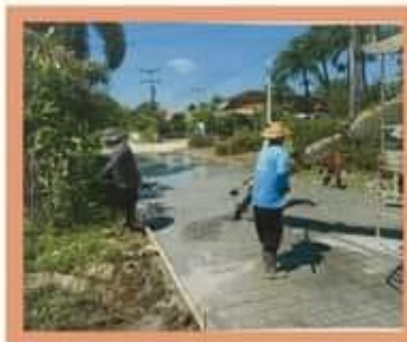
ภาพถ่ายระหว่างดำเนินการ
