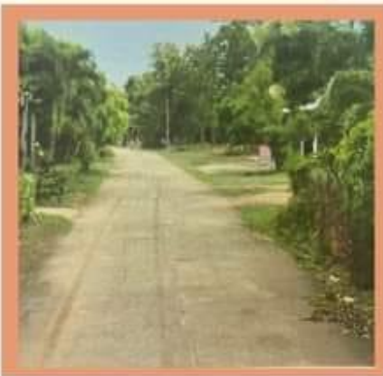
ภาพถ่ายก่อนดำเนินการ
