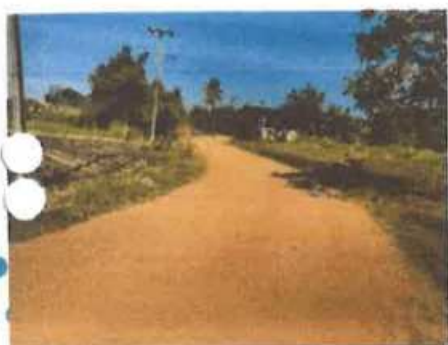
ภาพถ่ายก่อนดำเนินการ
