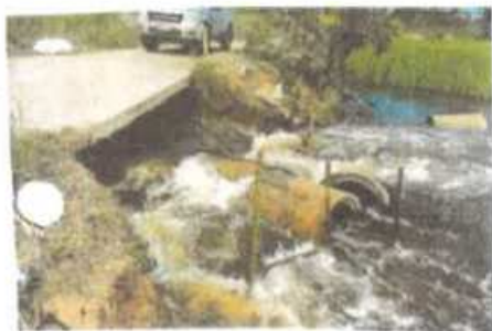
ภาพถ่ายก่อนดำเนินการ
