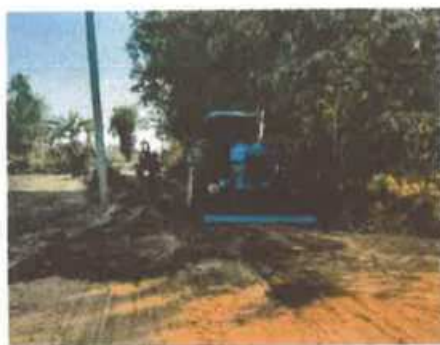
ภาพถ่ายระหว่างดำเนินการ
