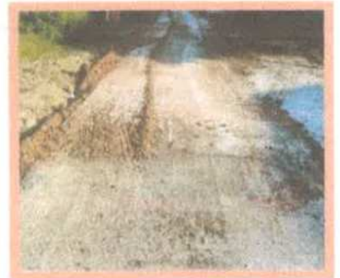
ภาพถ่ายหลังดำเนินการเสร็จสิ้น
