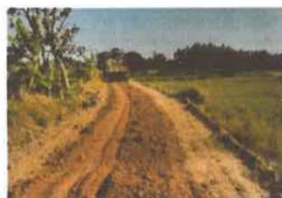
ภาพถ่ายระหว่างดำเนินการ
