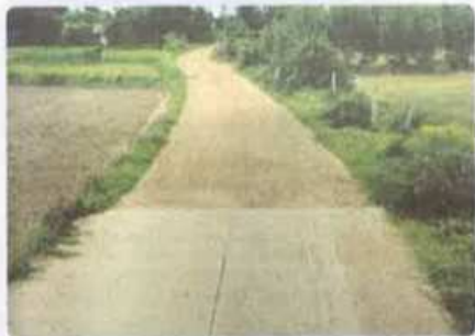
ภาพถ่ายก่อนดำเนินการ
