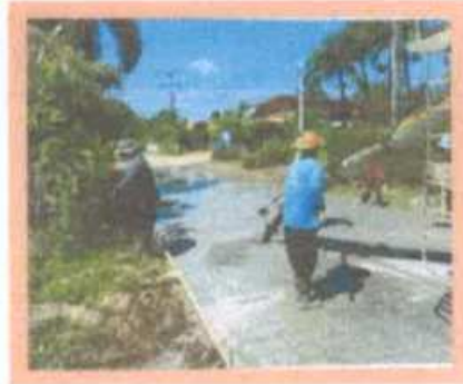
ภาพถ่ายระหว่างดำเนินการ
