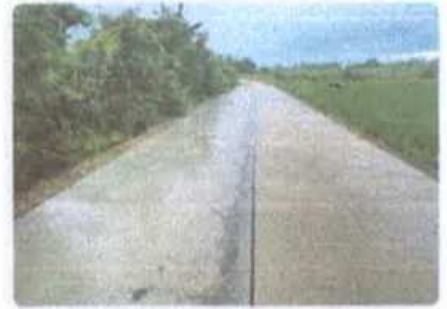
ภาพถ่ายหลังดำเนินการเสร็จสิ้น
